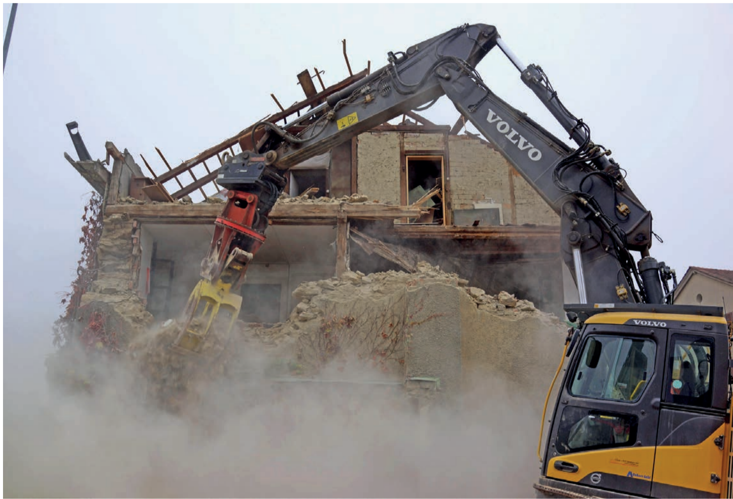
Das Wäldchen ist weg und bald ist es auch das Haus. Auf dem Areal wird eine Überbauung mit 70 Wohnungen erstellt. Bild: zvg/Res Kaufmann
